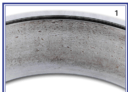
Indentaciones- Partículas de metal de otras partes fatigadas, sellado inadecuado o mantenimiento inadecuado. (1)
